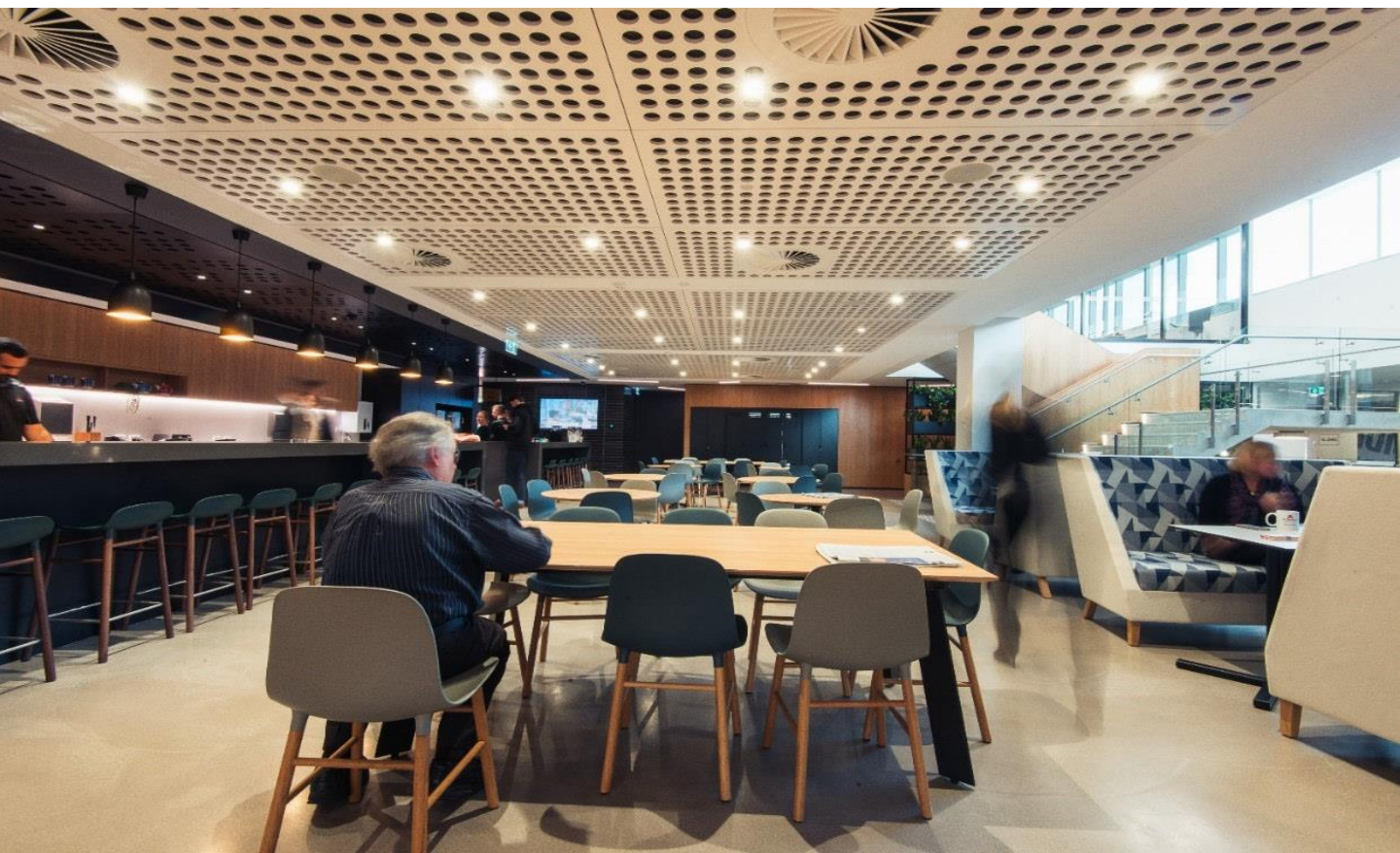
Absorción acústica del tipo Plano según Norma AS 1045 – 1998: NRC = 0,85. Panel Petcom HD 20 suspendido del techo a 400 mm.
